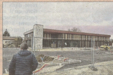
L'enrobé a été posé sur le parking du futur Burger King. Photo Progrès/Fabienne PYTHON
